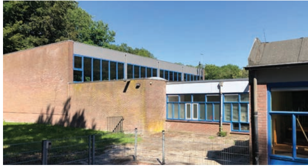
De Tille, Witteveen: Plat dak van de gymzaal: geschikt voor panelen
