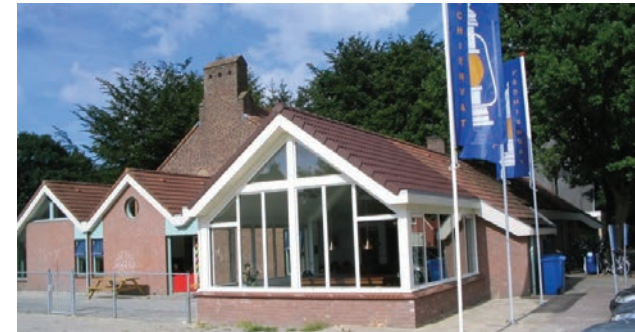
't Schienvat, Erica: vervanging van kozijnen deels toegepast
