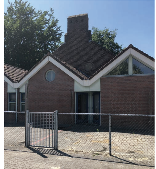
't Schienvat, Erica: Contrast in baksteengebruik (reliëf, formaat, kleur) bij het gebouw uit 1951, met een gladde steen bij de uitbouw (1990)
