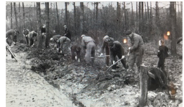
Het bouwrijp maken van de grond in Darp, 1958 (Beeldbank Drents Archief)
