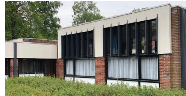
De Ludinge, Zuidlaren: Een houten gevel bekleding loopt over het gevelvlak
