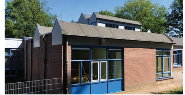
De Tille, Witteveen: Het vormgegeven dak met deels vlakke delen is geschikt als sedumdak
