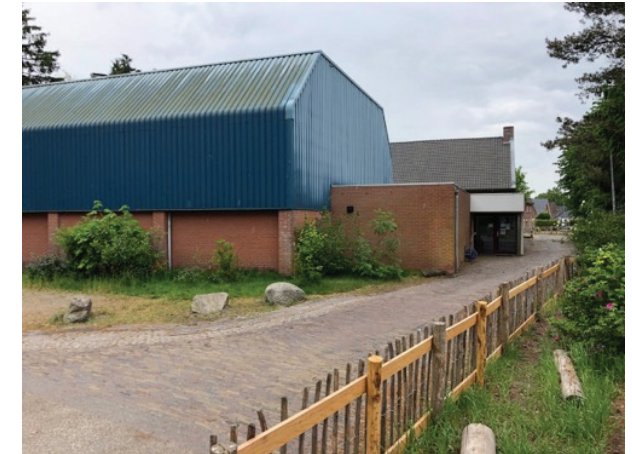
Zicht op achterzijde van het dorps huiscomplex
