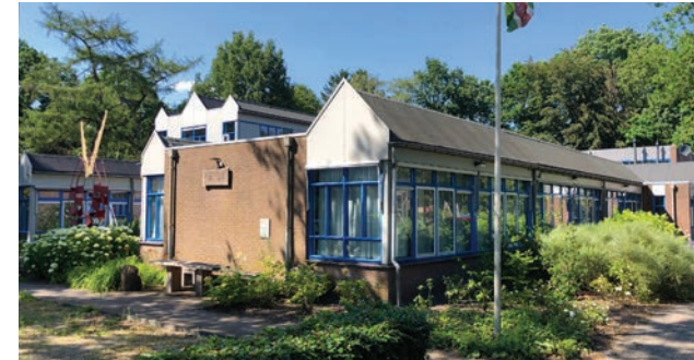
De Tille, Witteveen: in de zijgevel zijn vensters vervangen door aluminium kozijnen waar de middenstijl is verdwenen (zoals te zien in de kopgevel)
