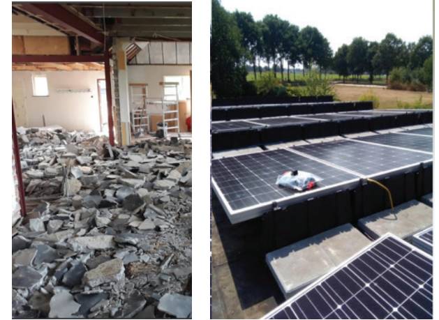
Het dorps-huis werd in 2018 grondig verbouwd en verduurzaamd (afbeelding: www.bokd.nl)
