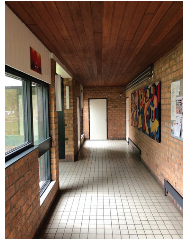
Detailering bij de kozijnen met schroten bovenplinten, langs de rechterwand twee ranke radiatoren
