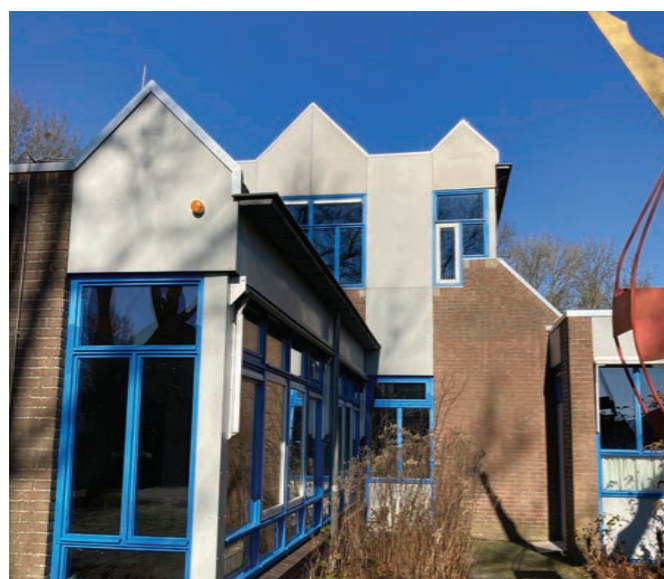
Gevel dorpshuis met verdieping.
