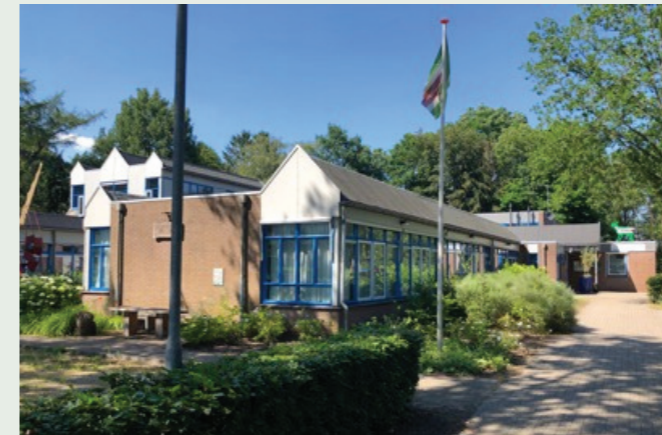
Zicht op de lokalen en entree
